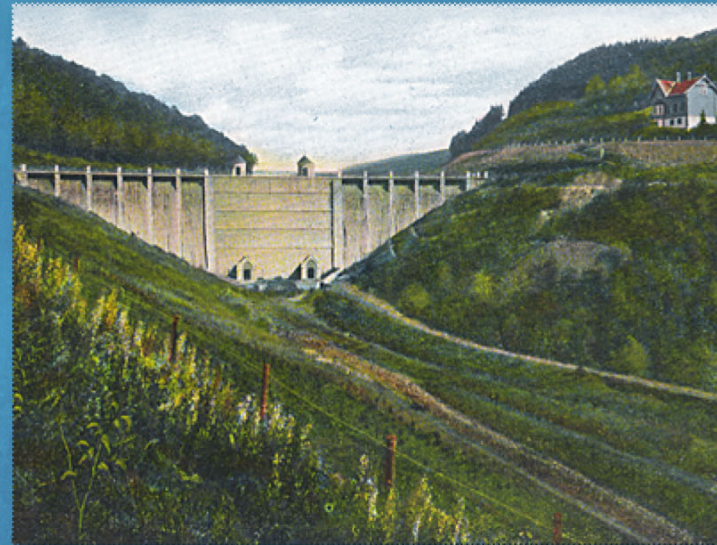
THYRTAL MIT TALSPERRE
