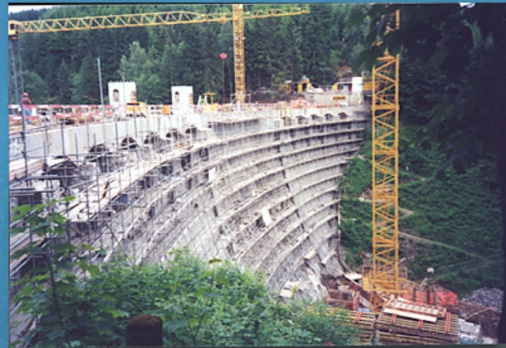
GENERALINSTANDSETZUNG LUFTSEITE
