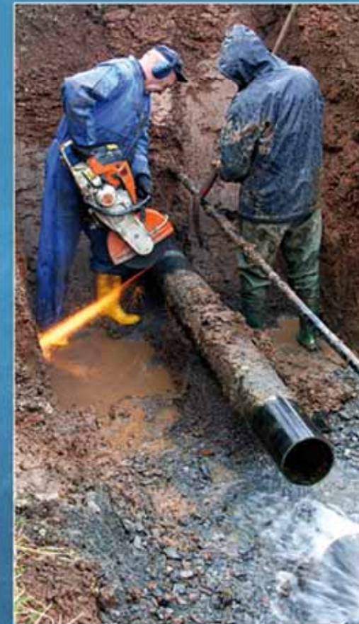
Arbeiten am Rohrnetz
