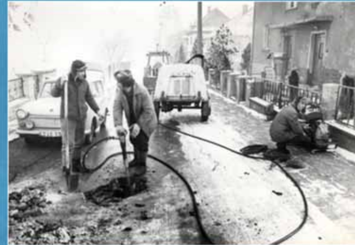
Arbeiten am Rohrnetz
