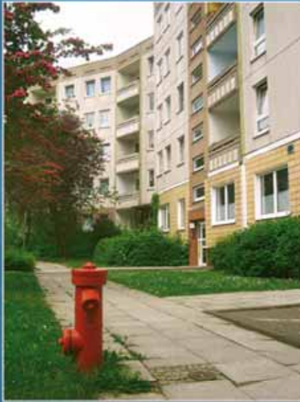
Neubaugebiet in Nordhausen Ost
