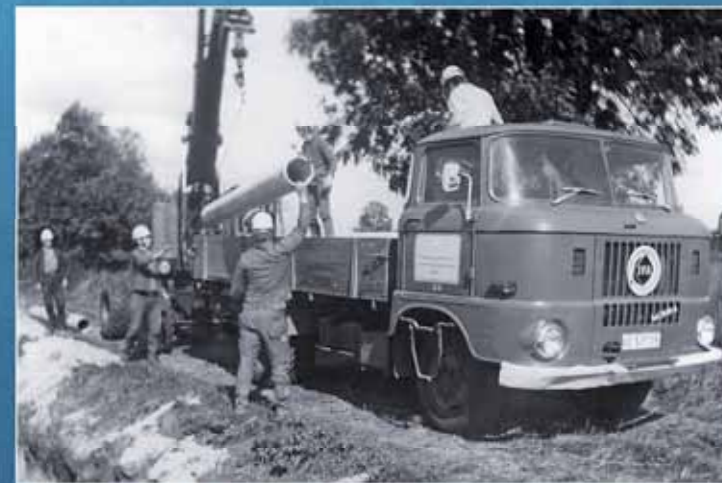
Verlegen von AZ-Rohren
