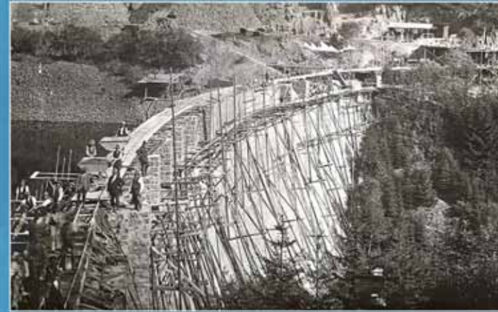
Talsperrenbau im Tiefen Tal
