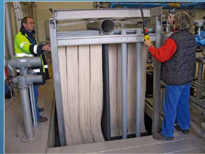
Einsetzen der Filter im neuen Wasserwerk
